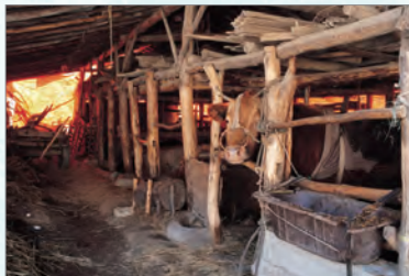
축사 ຄອກລ້ຽງສັດ ສຸດທ້າຍ ແບບເຮັດໃຫ້ສຸດທ້າຍ. ກວດສອບ ຫຼື ສ້ອມງ່າຍຫຼັງຄາຄອກລ້ຽງສັດ.
